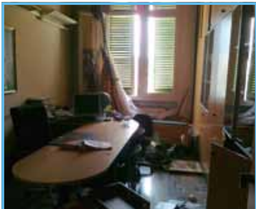
Uno degli uffici di Direzione devastato dalle scosse
