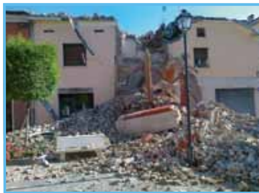
Il crollo della Torre dell'Orologio in Piazza Matteotti
